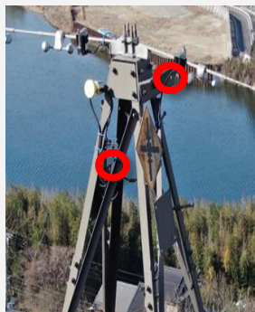
●鉄塔のボルト脱落検出例（左：検出後（赤丸部） 右：検出前）
